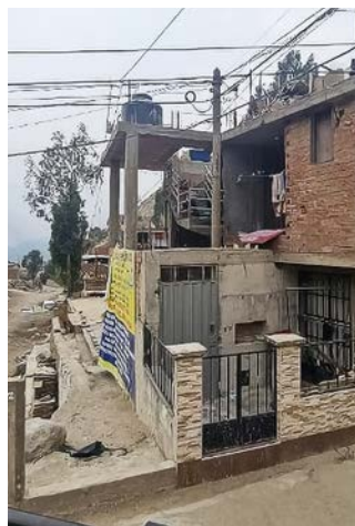
IMAGEN 2. Perú. Poste eléctrico incorporado en el área construida de la vivienda, Asociación Asentamiento Humano de Nicolás de Piérola en Luringancho-Chosica
