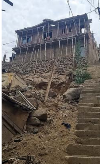
IMAGEN 1. Perú. Vivienda autoconstruida sin asistencia técnica sobre pircas inestables, Asociación Asentamiento Humano de Nicolás de Piérola en Luringancho-Chosica
